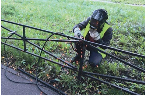
Ремонт газонных ограждений на Пращской улице, 37/3
