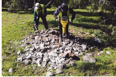
Уборка плит с территории сквера за домом 27 по улице Белы Куна
